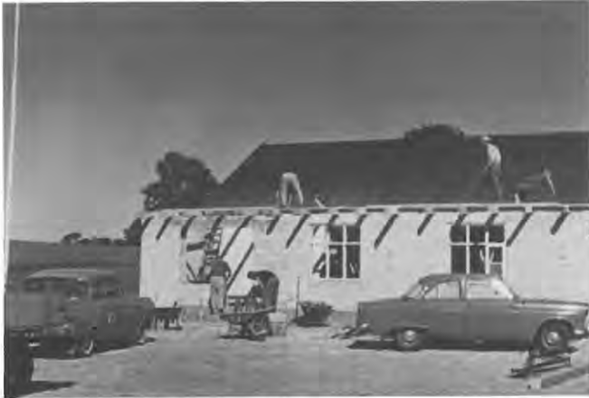
Fra byggeriet af loggiaen i 1965
